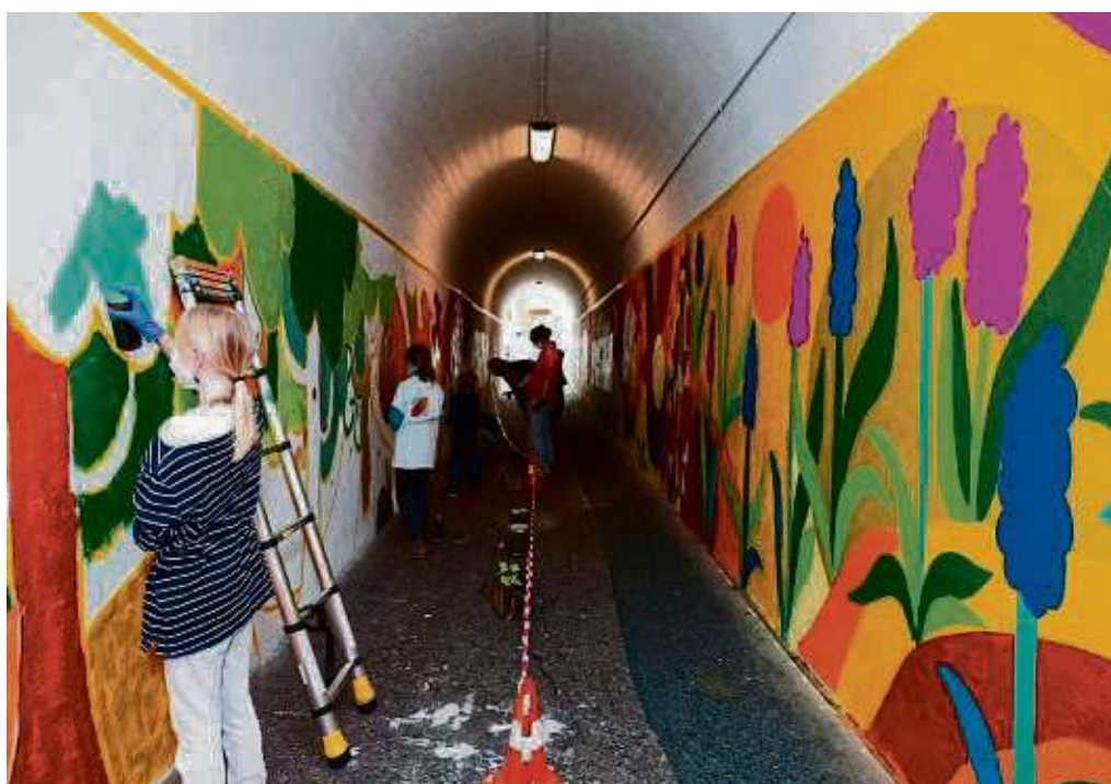
Da macht es sprüh, sprüh, sprüh... Eine Seite des Fußgängertunnels ist bereits fertig. Nun wird an der anderen Seite gearbeitet.
