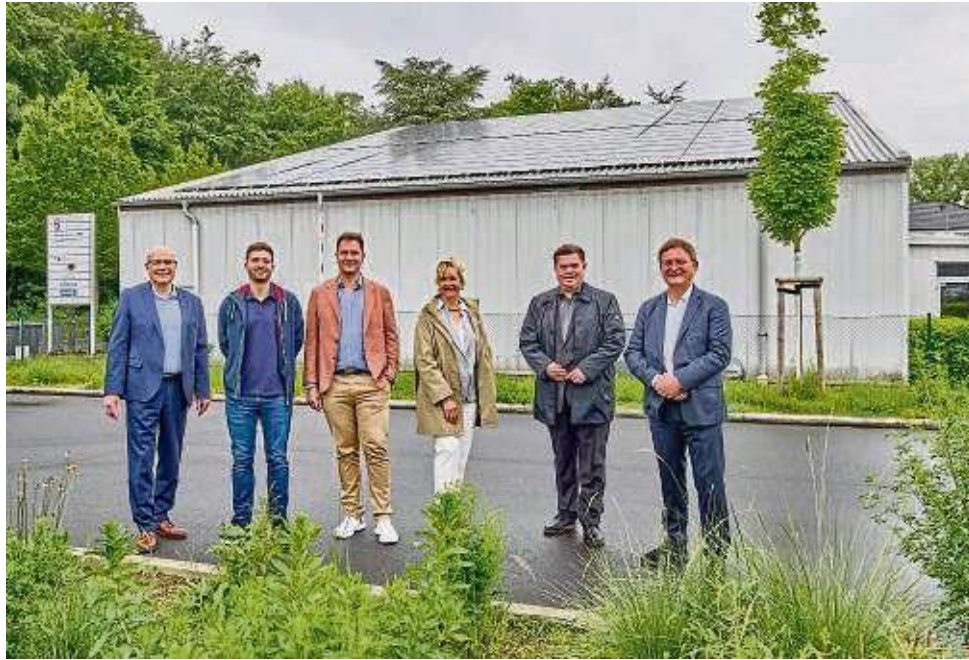
Die PV-Anlage auf der Halle wurde von den Stadtwerken installiert, den Strom nutzt vor allem Jeppesen-Boeing. Stadtwerke-Geschäftsführer Kirk Reineke, Sylvain Gorse (Senior Manager Data Operations bei Jeppesen), Westphal-Geschäftsführer Dr. Maximilian Westphal, Westphal-Inhaberin Sabine Westphal-Abrezo, Erster Stadtrat und Stadtwerke-Aufsichtsratsvorsitzender Stefan Schmitt und Bürgermeister Gene Hagelstein (von links).
