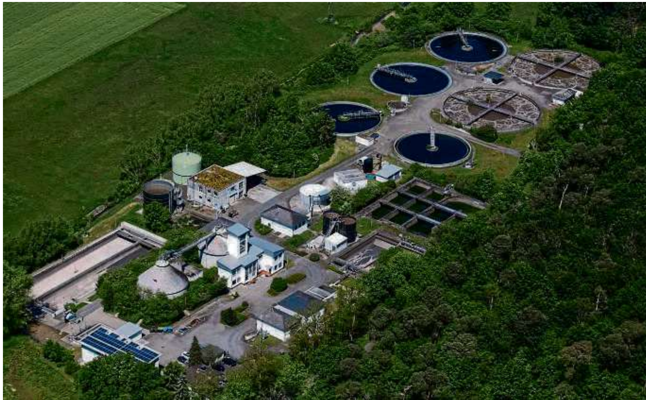
Die Kläranlage Weiskirchen behandelt das Abwasser bisher in drei Stufen: mechanisch, biologisch und chemisch. Eine vierte Stufe mit Aktivkohle und Tuchfilter soll in Zukunft auch Arzneimittelrückstände herausfiltern. Das geklärte Abwasser wird in die Rodau eingeleitet, die westlich entlang der Kläranlage verläuft.
