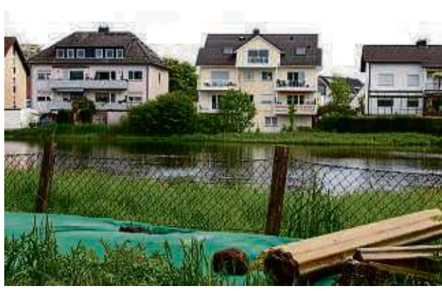
Das Wasser reicht jetzt auch bedrohlich nahe an Häuser entlang der Alfred-Delp-Straße heran.
