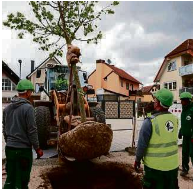
Mit dem Radlader setzt ein Arbeiter den Baum in die vorbereitete Pflanzgrube. Die Bäume wiegen etwa eine Tonne. FOTO: WOLF
