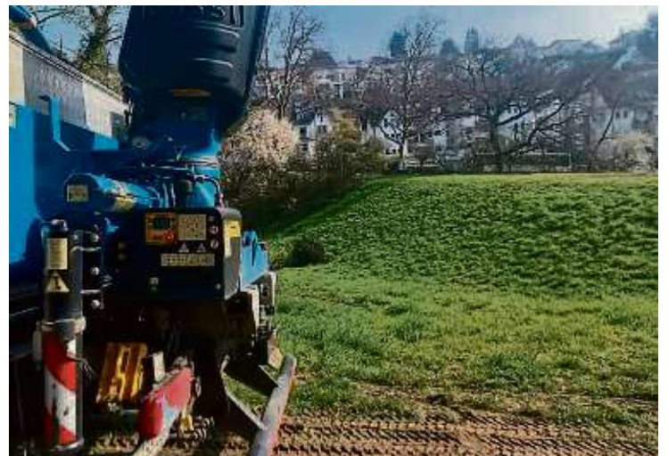
Läuft alles nach Plan, starten am Niederdorfsbach im kommenden Jahr die Arbeiten zur Erweiterung des Rückhaltebeckens. Foto: Stadt Bad Soden
