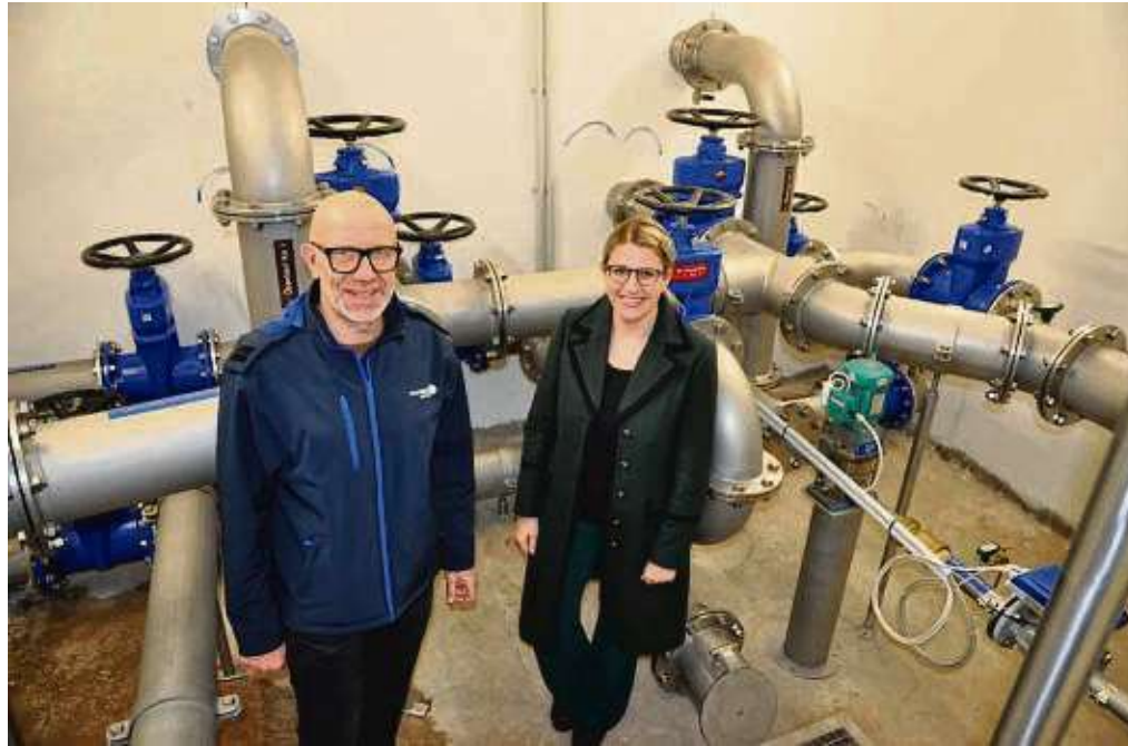
Julia Antoni und Dieter Gredig im sanierten Hochbehälter 3, der bereits 1911 gebaut wurde.
