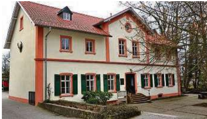
Das Hofhaus der Freiherren von Gagern in Hornau
