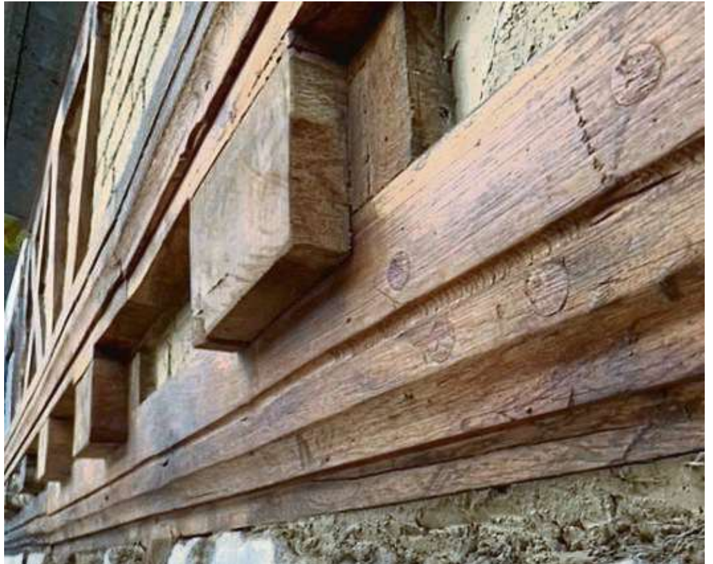
An der Südfassade wurden die Balken ausgetauscht.
