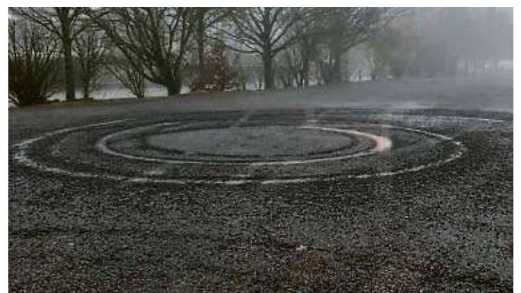
Gerade saniert und wieder zerstört: Eine unbekannte Person hat den frisch sanierten Festplatz in Bremthal beschädigt.
