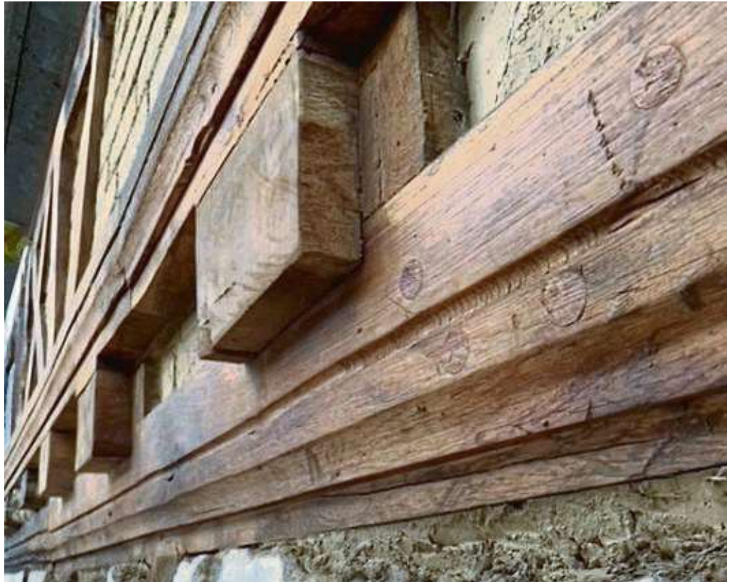
An der Südfassade wurden die Balken ausgetauscht.
