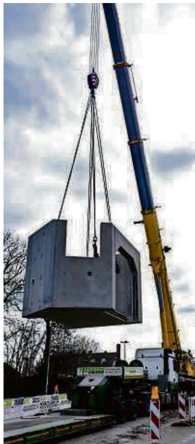
Passt... Der Schachteinbau in Höhe der Kreuzung Mühlheimer Straße / Kettelerstraße war Zentimeterarbeit. FOTO: P
