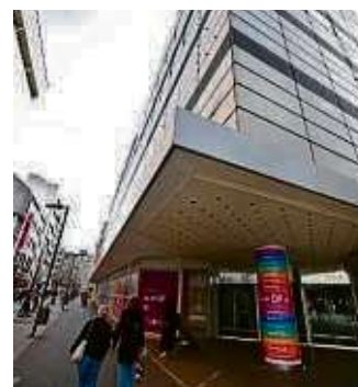
Im Kaufhof-Gebäude soll die Station Mitte entstehen. FOTO: STADT OFFENBACH
