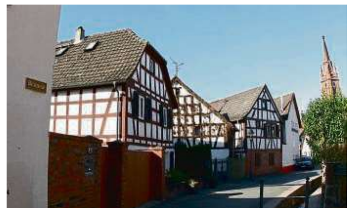
Die Fachwerkhäuser in der Langener Altstadt sind allesamt nach dem Modell des Ernhauses konstruiert. FOTO: STADT
