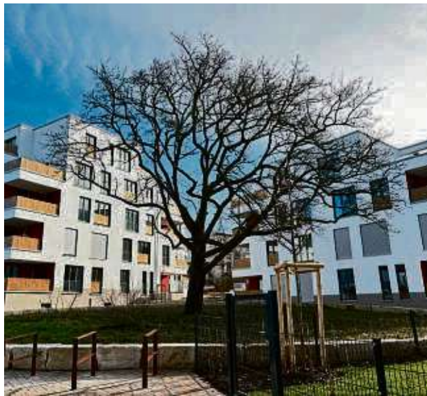
Zu den Bereichen , die 2023 den stärksten Zuzug erleben, gehört der Steinberg im Südosten der Stadt. Die Firma Kleespies hat dort das Neubaugebiet „Am Speierling“ mit 80 Eigentumswohnungen errichtet. FOTO: SCHUBERT
