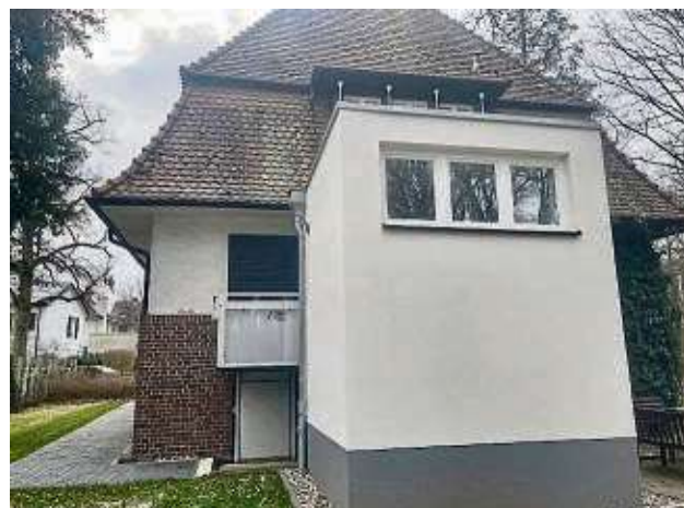
Der schlichte Anbau ermöglicht einen barrierefreien Zugang zur Begegnungsstätte: Nach gut einem Jahr Bauzeit kann das Gebäude nun wieder benutzt werden.
