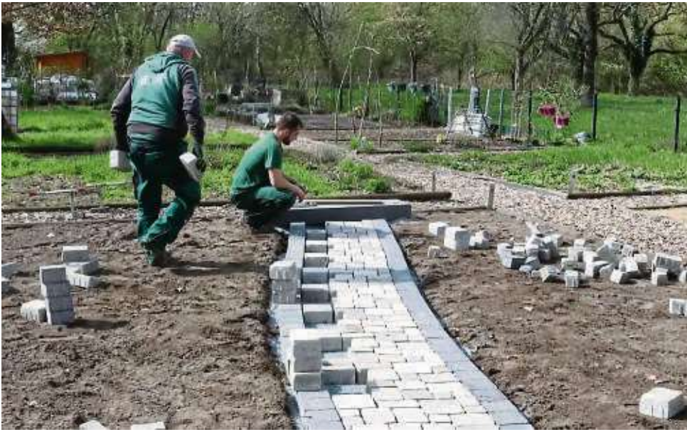
Hier entsteht der umweltfreundliche Naturgarten: Der Weg zur Haustür ist verlegt. Links und rechts von der Pflasterung wachsen bald pflegeleichte Stauden.
