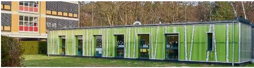
Der Neubau der Ludwig-Uhland-Schule soll noch in diesem Jahr aufgestockt werden. Im kommenden Schuljahr stehen zusätzliche Räume zur Verfügung. FOTO: POSTL
