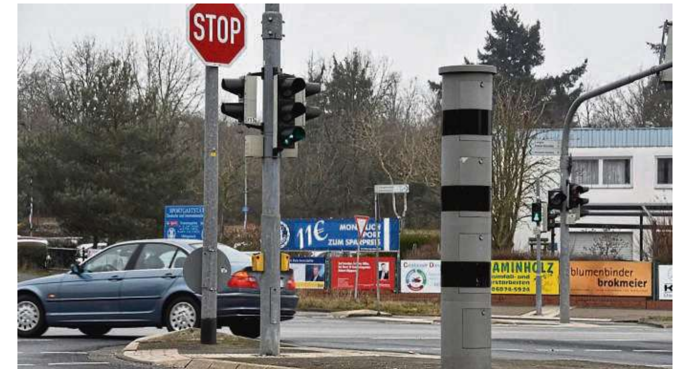
Neue Standorte: Die Stadt hat 2011 jeweils zwei Laser-Säulen an der SG-Kreuzung installiert. Doch auch anderen Orts wurden die Messgeräte aufgestellt, die die Starenkästen ersetzen.
