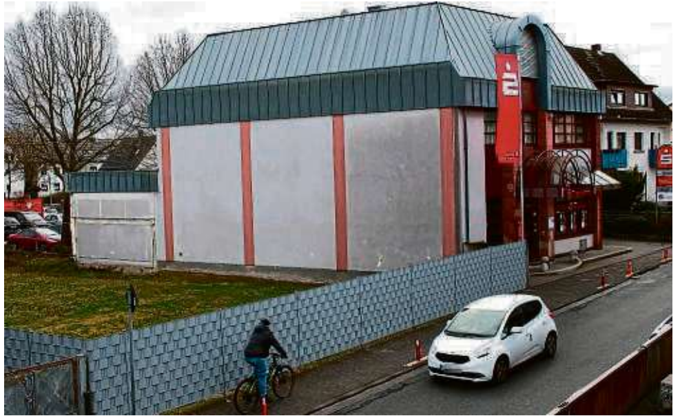
Vor etwa vier Jahren hatte die Sparkasse das angrenzende Nachbargrundstück (heute Rasen) gekauft. Perspektivisch soll daraus ein Parkplatz für Kunden werden. Jetzt wird allerdings zunächst einmal das Regionalcenter gründlich modernisiert. FOTOS: PELKA
