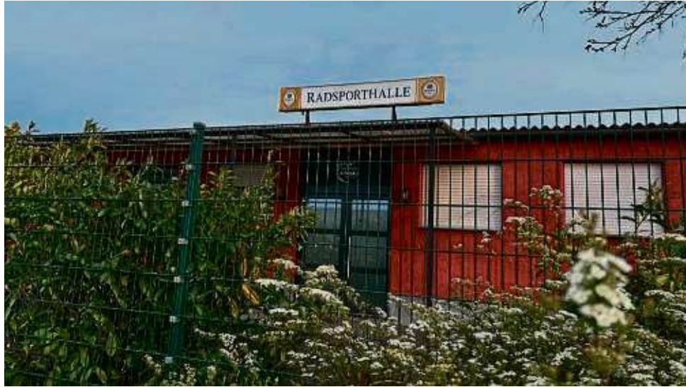
Wird momentan nur als Lager und Ausweichplatz für Gymnastikstunden genutzt: Die Radsporthalle an der Elbinger Straße.
