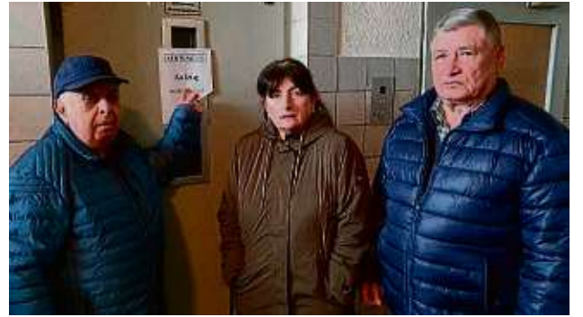
Sind sauer auf die Hausverwaltung: Roman Binov, Tatjana Rusinava und Leonid Vasilevsky (von links) stehen vor einem defekten Aufzug. Seit Monaten ist er außer Betrieb, berichten die Bewohner des Hochhauses an der Taunusstraße.
