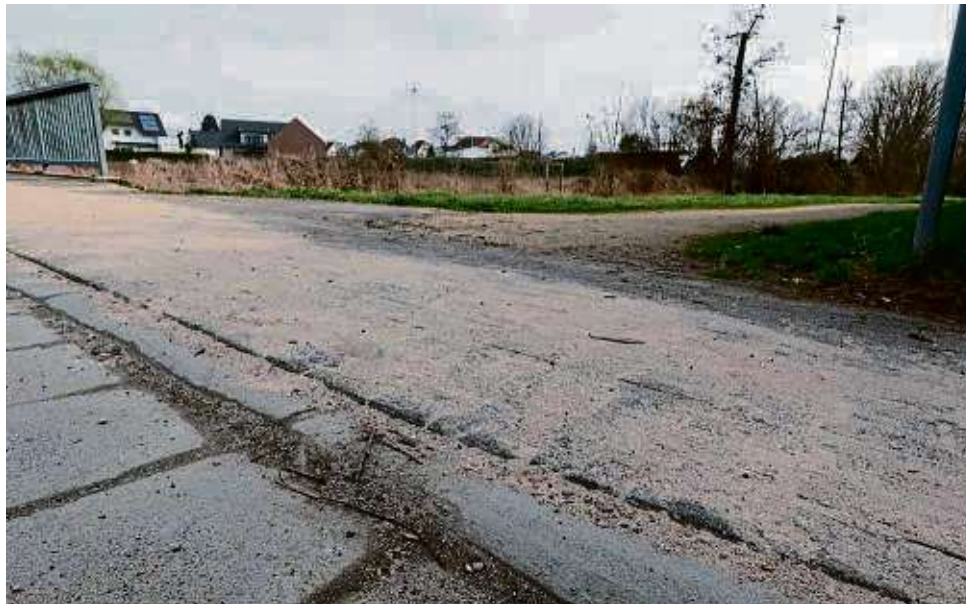
Abgesenkte Bordsteine erleichtern Fahrradfahrern den Übergang zwischen Straße und Radweg, wie hier an der Egerstraße in Jügesheim.
