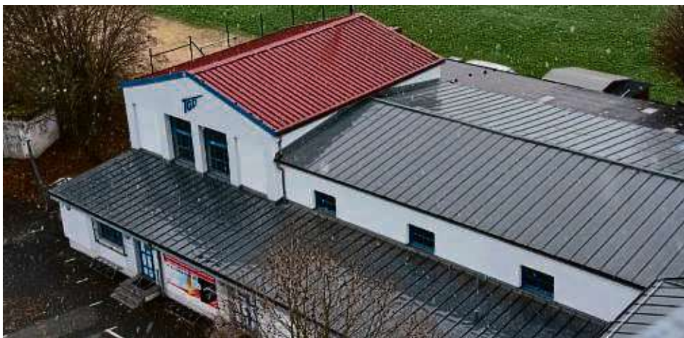
Neuanschaffung notwendig: TG Dietzenbach will Strahlheizung und Lüftungsanlage kaufen. FOTO: ANS
