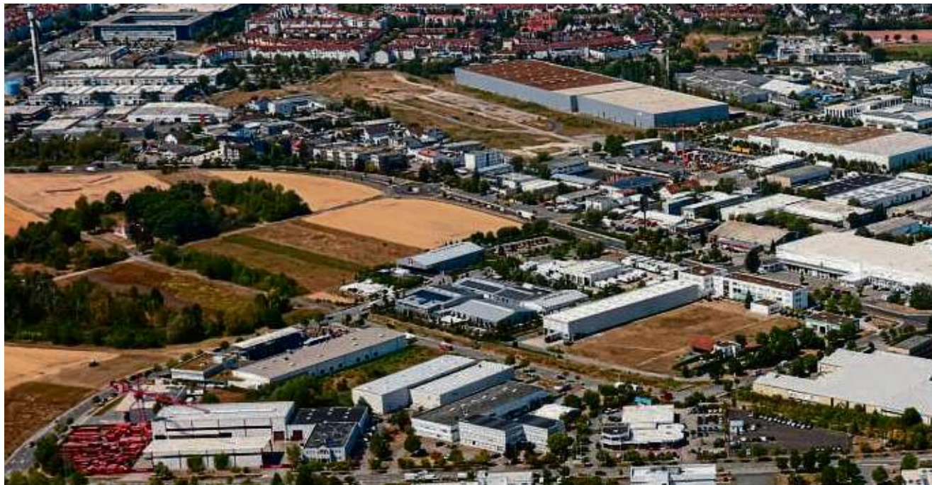
Neuansiedlung in der Assar-Gabrielson-Straße: Das Rechenzentrum Main Cube wird auf das Grundstück ziehen, auf dem das Unternehmen Teknihall Elektronik ansässig war.
