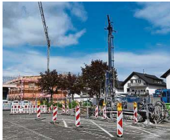
Geplante Nutzung der Erdwärme: Neun Bohrungen in fast 100 Metern Tiefe am neuen Rathaus.
