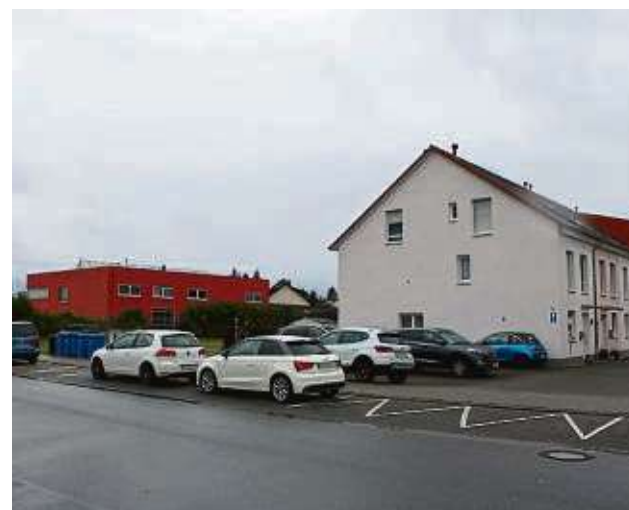
In der August-Horch-Straße 18 in Dieburg ist genehmigt, was die Bauaufsicht beim Landkreis Darmstadt-Dieburg dem Rodgauer Bauträger Martin Yüce um die Ecke im Nordring 138 verbietet: Die Wohnbebauung (hier Reihenhäuser) grenzt unmittelbar an Gewerbegrundstücke (links).
