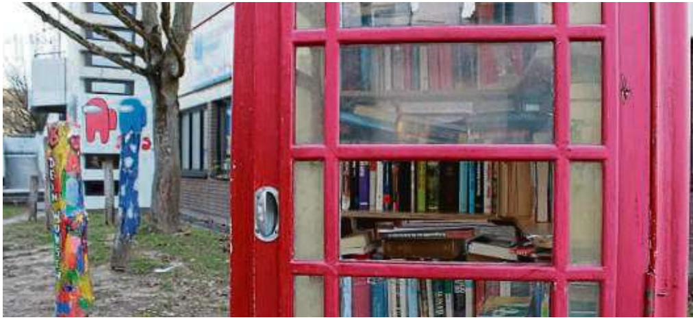
Zerkraetzter Lack und eingeschlagene Scheibe: Die Bücherzelle am Puiseauxplatz macht einen ramponierten Eindruck. Innen stapeln sich die Bücher sogar auf dem Boden. FOTO: WOLF
