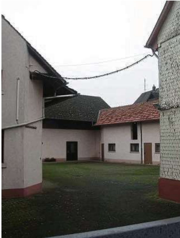
Die Nebengebäude eignen sich nach Ansicht des Magistrats für eine gewerbliche Nutzung. FOTO: WOLF
