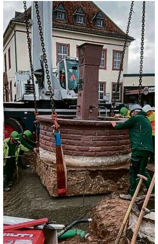
Stadtumbau Dudenhofen: Ein Kran hat den schweren Brunnen auf einen neuen Sockel gesetzt. Das war Maßarbeit. FOTO: STADT
