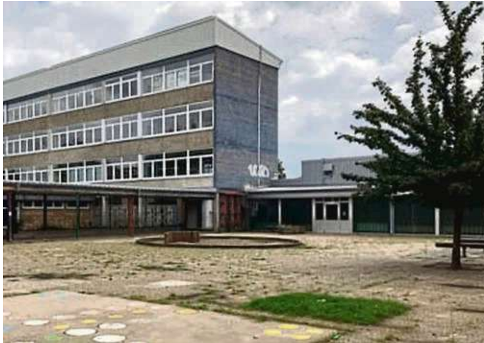
Links das Flachdach-Gebäude der Eulenhof-Schule, das saniert wird, rechts der Hochbau der Georg-Büchner-Schule. Durch ihre Nähe ist die Nachbarschule unmittelbar vom Baulärm betroffen.
