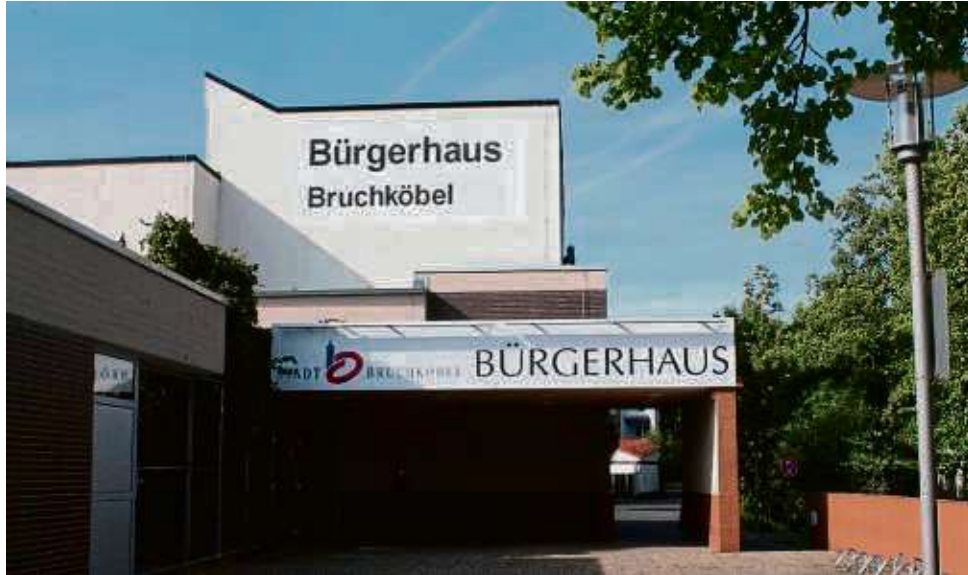
Für die Öffentlichkeit schon lange geschlossen: das Bruchköbeler Bürgerhaus, dessen Abriss laut Investor nun im April beginnen soll.
