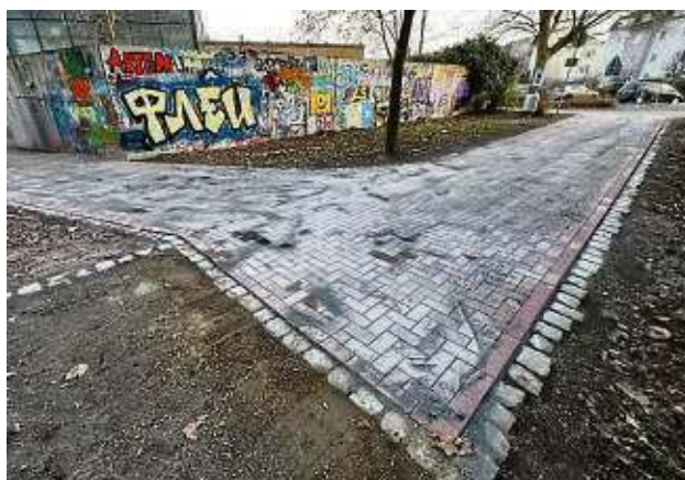
Der Zuweg über den Erlenpark wurde instand gesetzt und Pflasterflächen angelegt, sodass die Bürgerinnen und Bürger trockenen Fußes zum Servicebüro gelangen.
