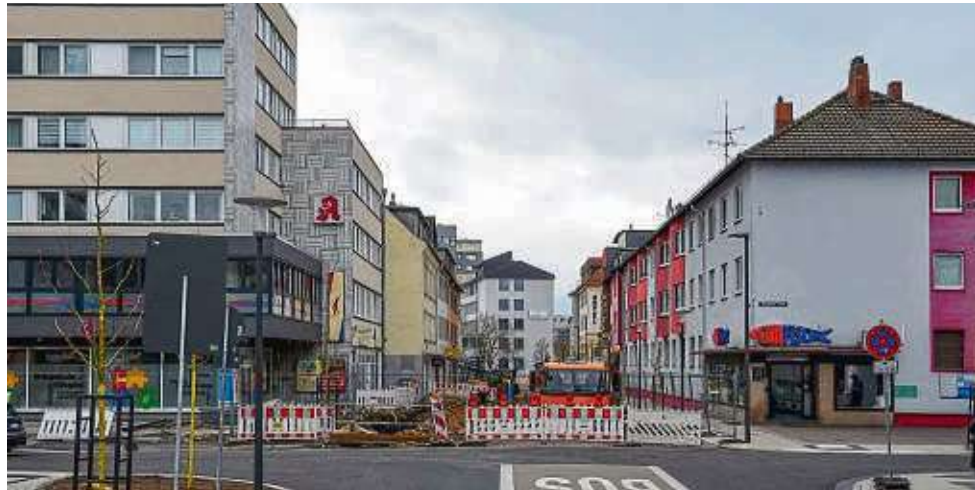
Die Römerstraße ist wegen der Bauarbeiten ab der Steinheimer Straße gesperrt. Nach Fertigstellung dieses Abschnitts wird das Teilstück bis zum Kanaltorplatz erneuert. FOTO: PM
