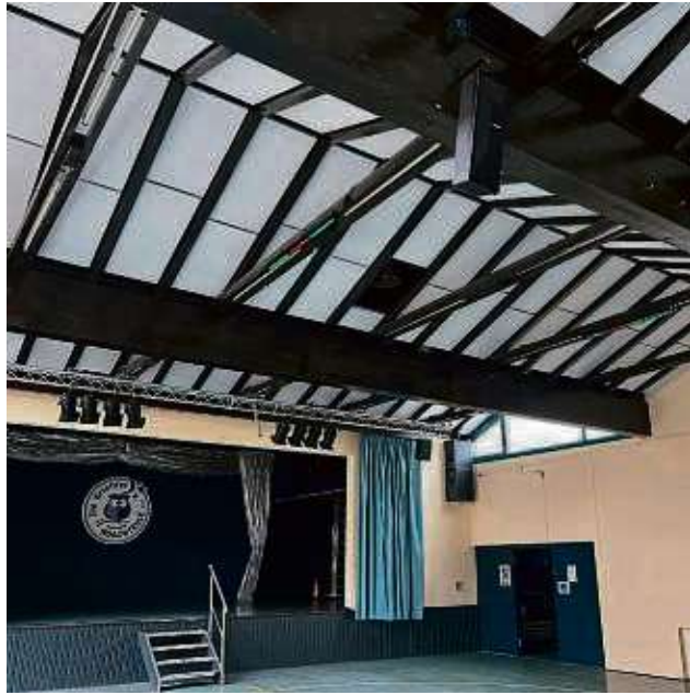
Eine neue Deckenverkleidung sorgt dafür, dass bei Veranstaltung in der MZH die Akustik nicht leidet. FOTO: PM
