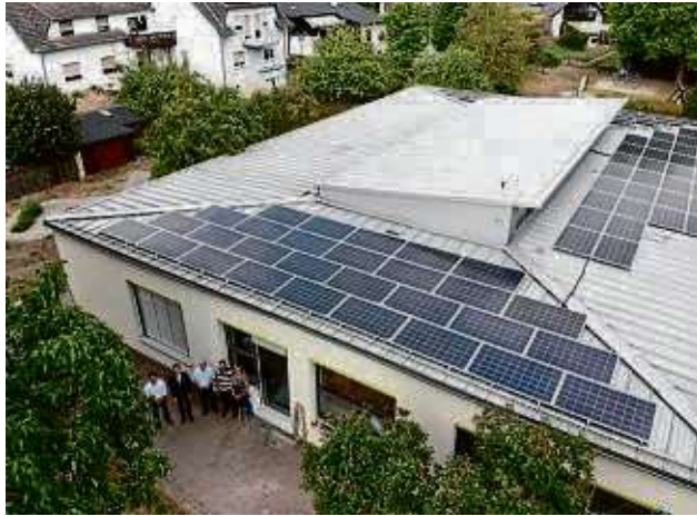
Auf vielen öffentlichen Gebäuden in Bruchköbel befinden sich Photovoltaikanlagen: Unser Bild zeigt die Kita Hasenburg.
