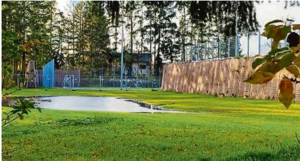
Planungsfehler? Nicht nur am Kleinspielfeld, auch zwischen den Hauptspielfeldern klaffen in Richtung Wohnbebauung im Lärmschutzwand des Sportzentrums Dicke Buche in Dörnigheim mehrere Meter breite Lücken.
