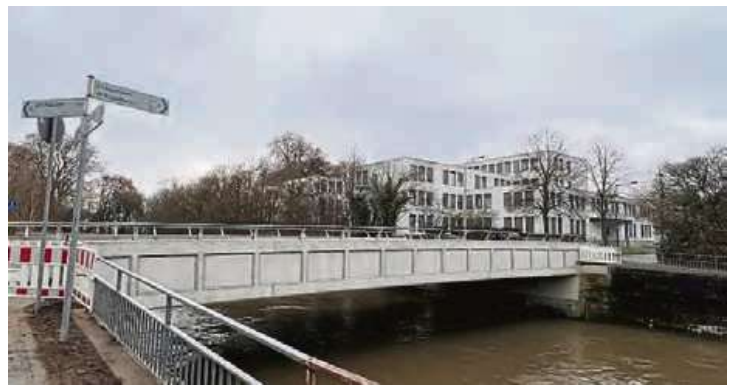
Die neue Niddabrücke zwischen Rödelheim und Hausen.
