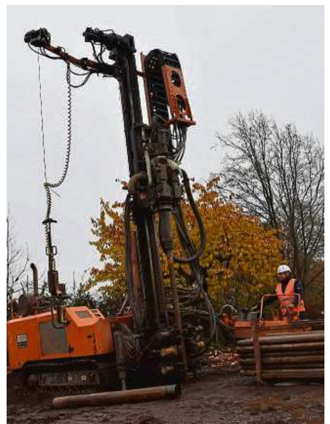
Vor rund einem Jahr wurde auf dem Gelände der Alten Stadtgärtnerei eine Erkundungsbohrung durchgeführt. Das Ergebnis hat Geologe Sven Rumohr nun im Bauausschuss vorgestellt. ARCHIVFOTO: ANS
