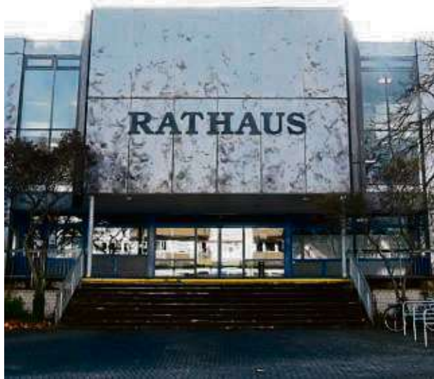
Die Tage des Rathauses an der Schubertstraße sind gezählt. Das Projekt Rathaus/Stadthaus-Neubau nimmt Fahrt auf. Foto: prochnow
