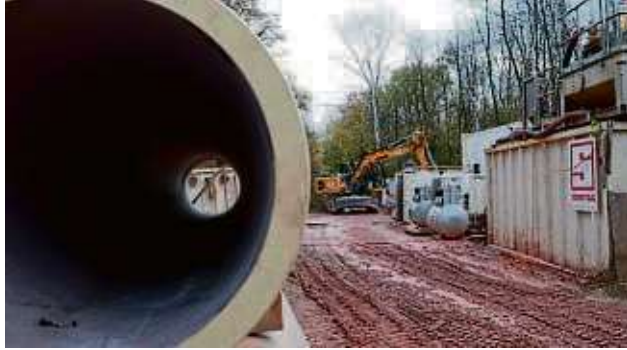
Die Verlegung der neuen Druckleitung erfolgt derzeit im Bereich des Flughafenwäldchens. FOTO: PM
