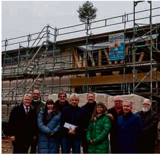
Gäste aus dem schulischen und politischen Kontext freuten sich über das Richtfest des Neubaus an der Wilhelm-Busch-Schule in Dörnigheim.
